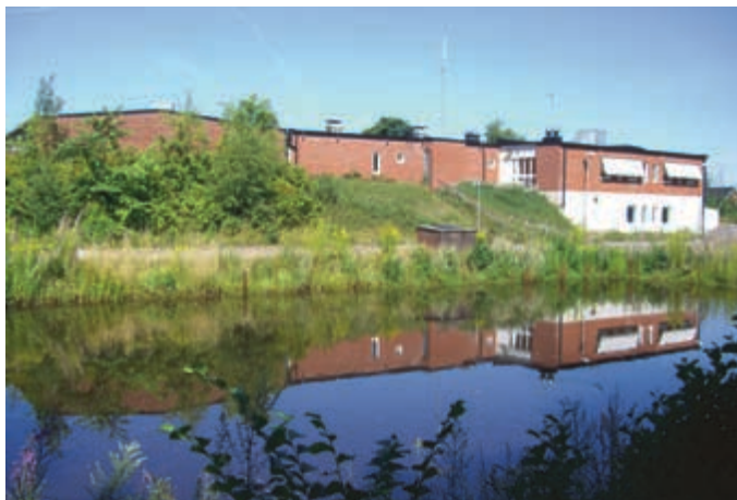
Vattenverket på Ljungsgård.
