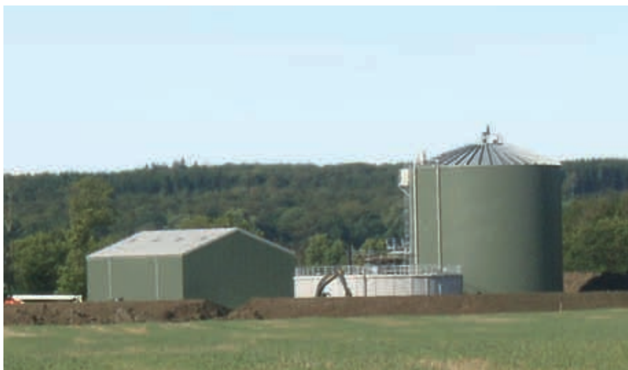
Biogasanläggningen vid Evadal (mellan Knäppe och Tegeldammshuset).
