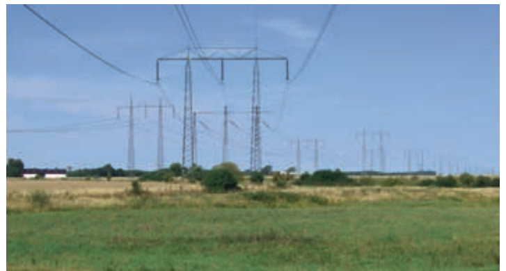
Luftburna ledningar så långt ögat når...
