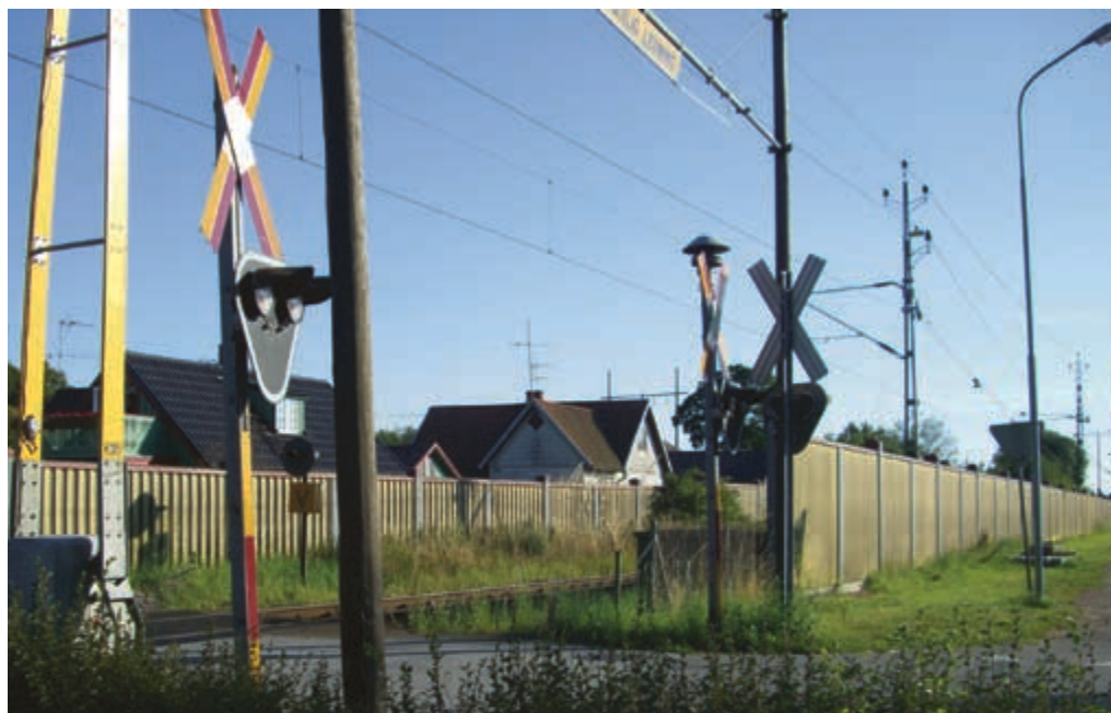
Bullerskärmar vid järnvägsövergången av Sjukhusvägen.
