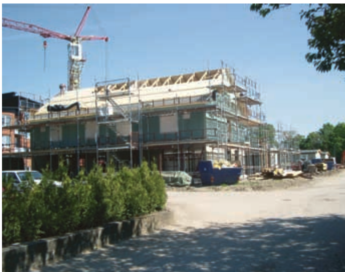
Kvarteret Ulven tar form. Nya hyreshus vid Hantverkaregatan.
