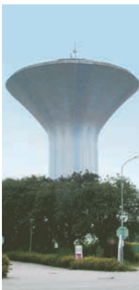
Vattentornet i Bjuv - 40 m högt. Byggt 1964.
